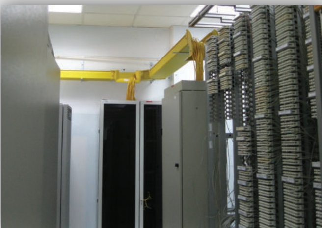
W ofercie wyposażenie serwerowni m.in.: szafy centralowe, przełącznice, pigtaile, patchcordy, adaptory oraz dukty kablowe.
