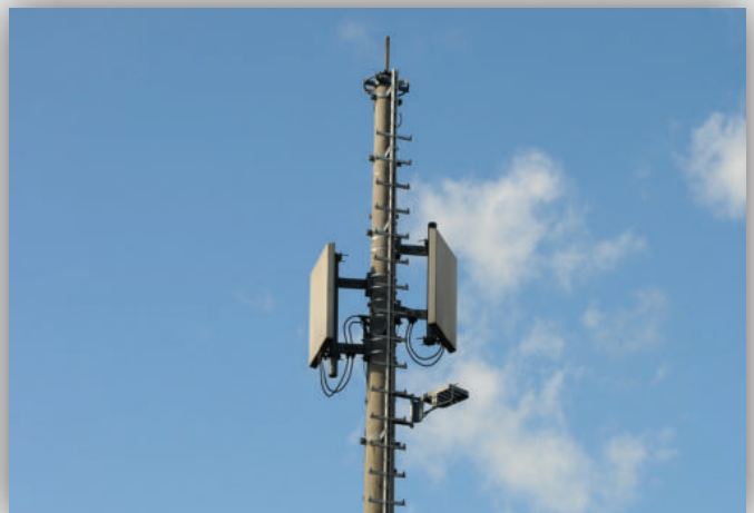
W ofercie firmy OPTOMER znalazły się także sieci FTTA, które są wykorzystywane do budowy stacji bazowych GSM oraz LTE.
