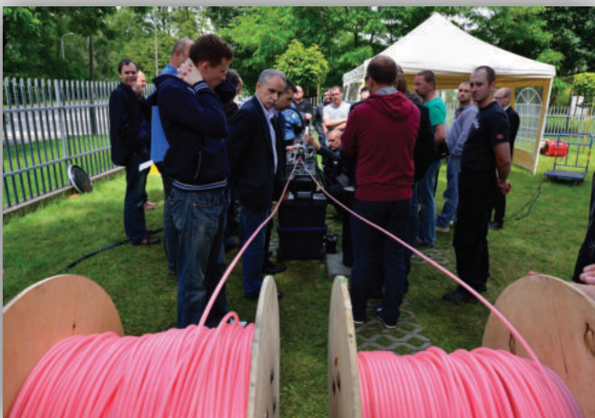
Dostarczenie mikrokanalizacji połączone ze szkoleniem pracowników.
