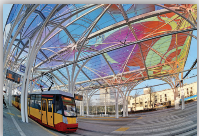
Dostarczenie produktów do budowy Inteligentnego Systemu Transportowego w Łodzi.
