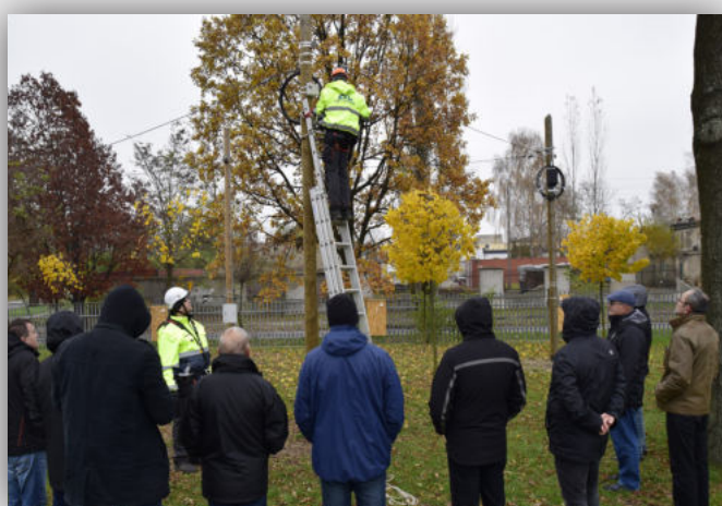
Szkolenia prowadzone przez firmę OPTOMER są podzielone na część teoretyczną i praktyczną, która odbywa się na przykładowych instalacjach.
