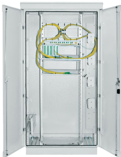
Przełącznica uliczna PU-10 z wyposażeniem FTTx
