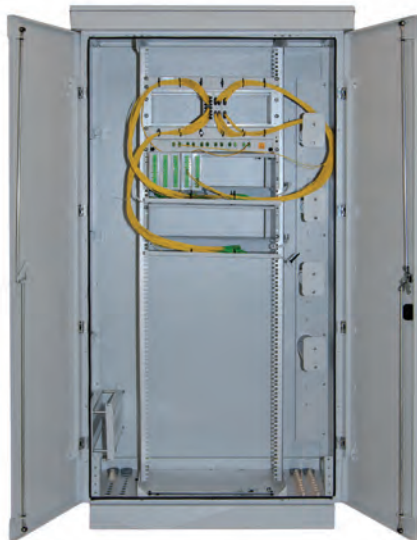
Przełącznica uliczna PU-10 z wyposażeniem FTTx
