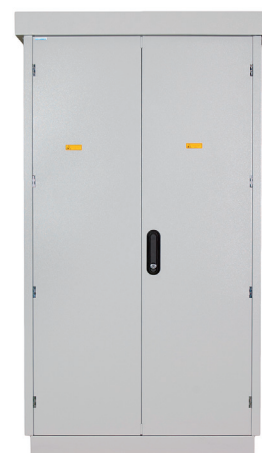
Przełącznica uliczna PU-7
