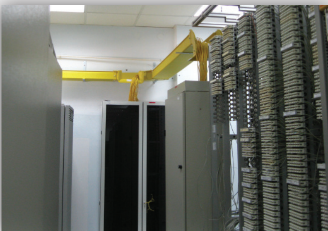
W ofercie wyposażenie serwerowni m.in.: szafy centralowe, przełącznice, pigtaile, patchcords, adaptory oraz dukty kablowe.
