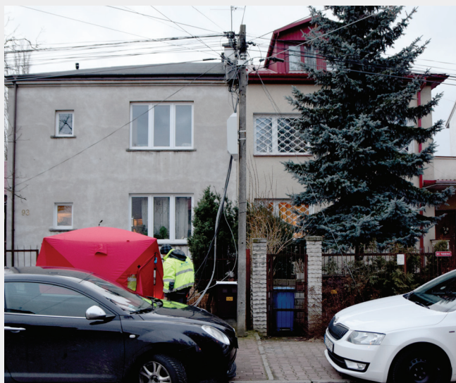
Spawanie przełącznicy w namiocie pomimo montażu OSS+PSHN na wysokości ponad 3 m
