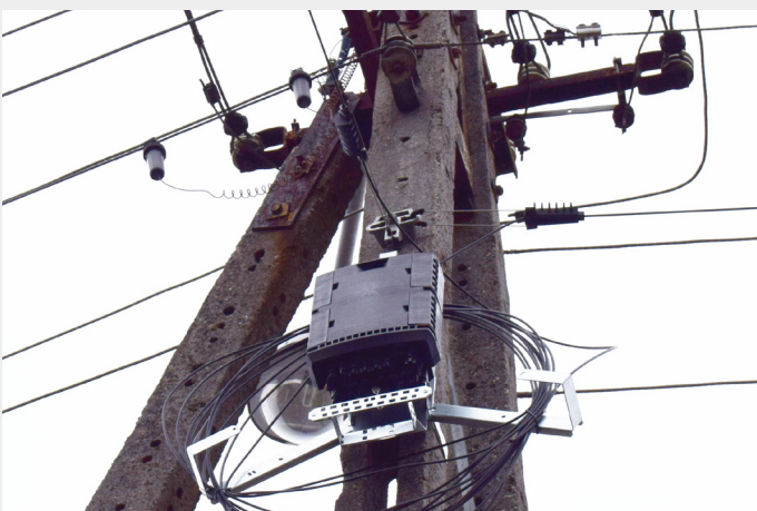
Uzupełnieniem jest Mufa OSS-ZSD-48/24 ze Stelazem Zapasu Dostępowym OSS-SZD-80.
