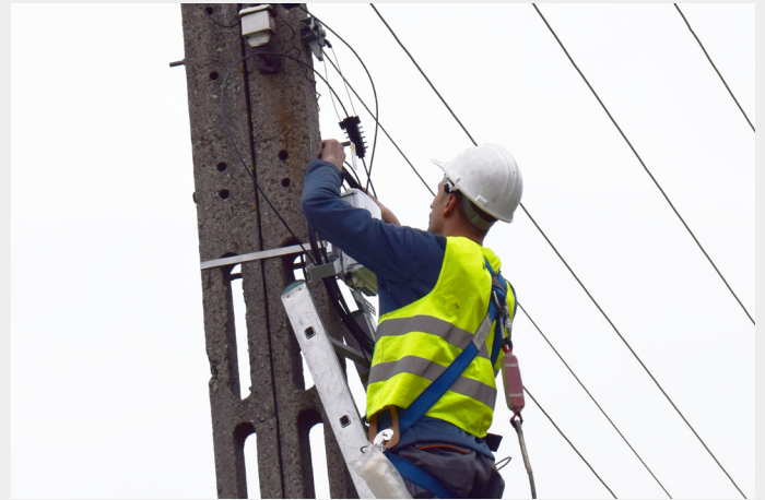
Przewagą sieci napowietrznej FTTH nad mikrokanalizacją jest szybkość budowy – dziennie może powstać do 5 km sieci.
