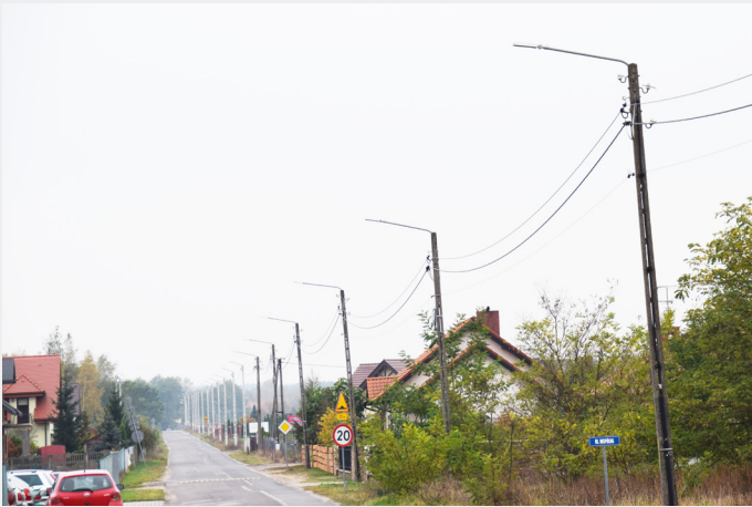
Przykładowa sieć napowietrzna FTTH objęła blisko 400 punktów HP.
