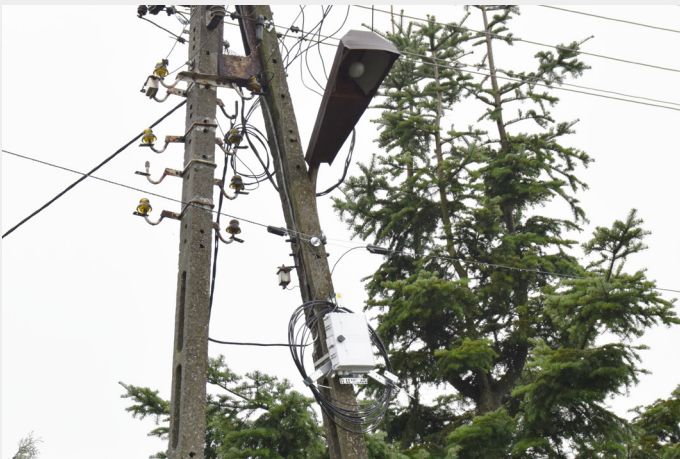
Głównym elementem sieci są Mufy OSS-ZSD-24/8 ze Stelazem Zapasu Dostępowym OSS-SZD-60.
