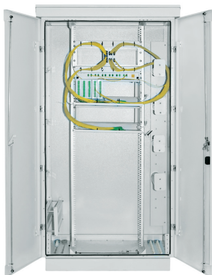
Przełącznica uliczna PU-10 z wyposażeniem FTTx
