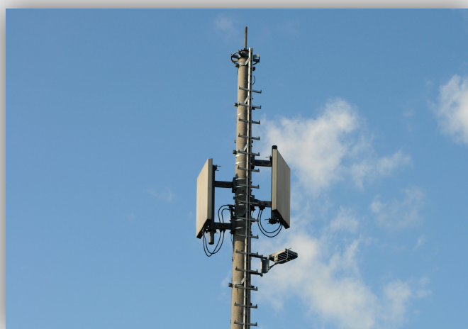
W ofercie firmy OPTOMER znalazły się także sieci FTTA, które są wykorzystywane do budowy stacji bazowych GSM oraz LTE.
