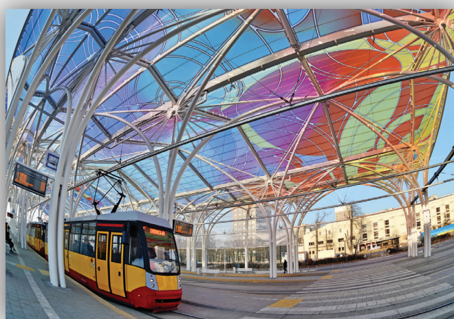
Dostarczenie produktów do budowy Inteligentnego Systemu Transportowego w Łodzi.
