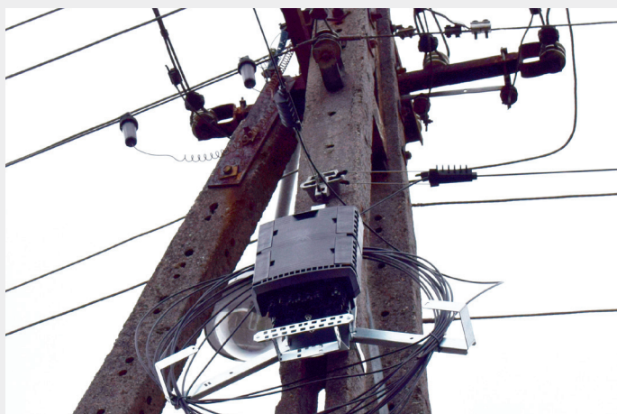
Uzupełnieniem jest Mufa OSS-MUF-7 ze Stelażem Zapasu Dostępowym OSS-SZD-80.
