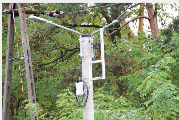
Dział Konstrukcji firmy OPTOMER na potrzeby sieci opracował wspornik odsuwający kabel od słupa.
