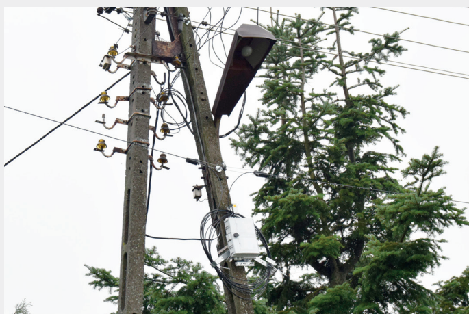
Głównym elementem sieci napowietrznej FTTH są Mufy MUF-8 ze Stelażem Zapasu Dostępowym OSS-SZD-60.
